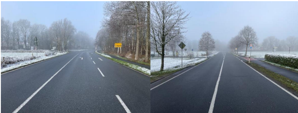
Abbildung 3: Leeraner Straße (L 821)
